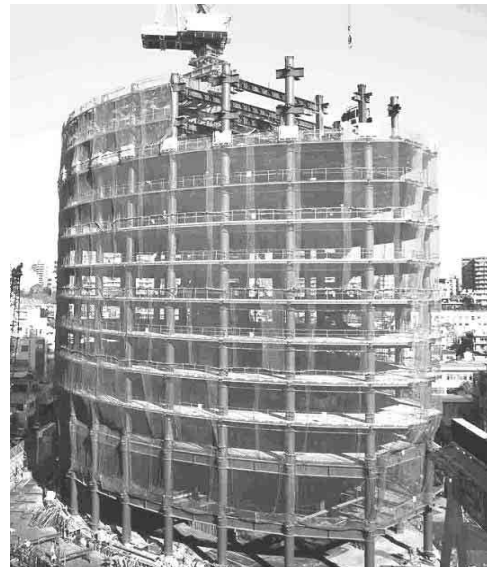
写真 1 円形鋼管柱を採用した物件例
